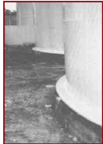
Figura 89. Tanques no anclados que desarrollaron pandeo de tipo "pie de elefante" al extremo que la cáscara se dobló hacia atrás sin romperse en Moin, Costa Rica.
