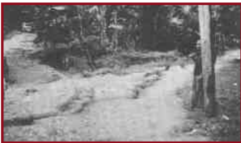
Figura 70. El flujo lateral produjo el agrietamiento del terreno en Agoo, Filipinas.
