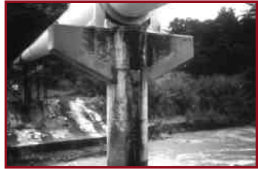
Figura 73. Ampliación de apoyos y base deslizante de tubería de conducción en el acueducto de Orosi, Costa Rica, que aseguran su correcto comportamiento en caso de sismos
