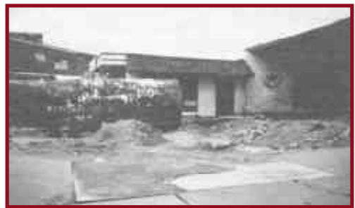
Figura 46. Tanques de combustible enterrados en Dagupan, Filipinas, que flotaron en suelo licuado.
