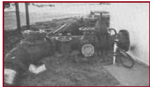
Figura 82. Conexión reparada en el tanque de Scotts Valley, California.
