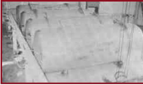
Figura 42. Los cilindros de cloro de una tonelada amarrados con doble cadena se sostuvieron bien durante el terremoto de Loma Prieta en Santa Cruz, California.
