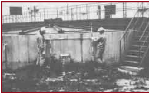
Figura 22. Tanque de aguas residuales que flotó debido a la licuefacción en Niigata, Japón.
