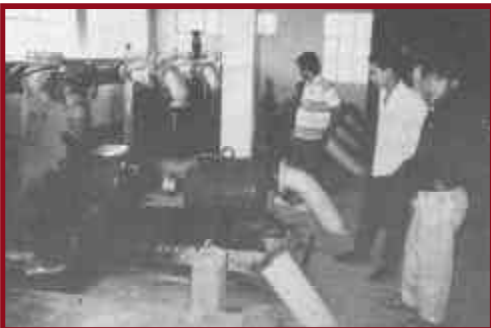
Figura 59. Motor de bomba grande que se quemó debido a la oscilación de voltaje en la estación de impulsión de Baguio, Filipinas.
