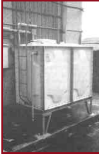
Figura 48. Soportes arriostrados en estructura de apoyo de tanques en Japón.
