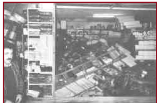
Figura 51. Estantes de almacenamiento de repuestos de autos que se volcaron en el terremoto de Erzincan, Turquía.
