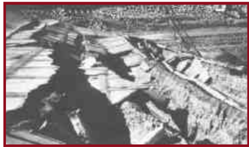
Figura 17. Represa del reservorio Lower Van Norman (California) que estuvo a punto de colapsar.
