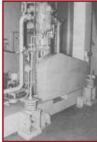
Figura 37 y 38. Amortiguadores diseñados en Nueva Zelanda (37) y fabricados en Estados Unidos (38) para aislar vibraciones.
