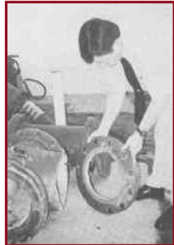
Figura 81. Empalme roto en un tanque no anclado en Scotts Valley, California, luego del terremoto de Loma Prieta.
