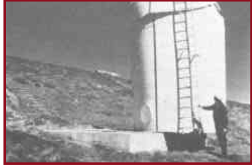
Figura 87. Tanque de productos químicos no anclado que se deslizó en San Fernando, California.
