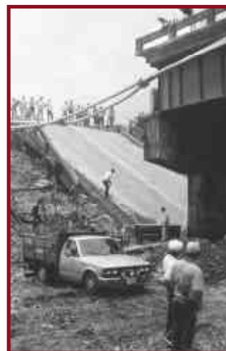
Figura 74. Colapso de un puente debido a un sismo que puso en riesgo las tuberías de conducción de agua potable.
