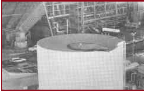
Figura 90. Perno de anclaje que se extendió luego del terremoto de San Francisco.
