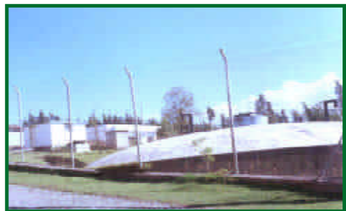
Segundo tanque de almacenamiento de agua o reserva Álvarez Chiriboga, ciudad de Cayambe, cantón Cayambe, provincia de Pichincha.
